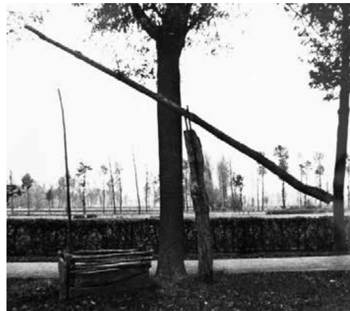
De eenvoudige houten opbouw van een put in Deurne, ca 1935. Wellicht hebben we hier nog te maken met een plaggenput.
