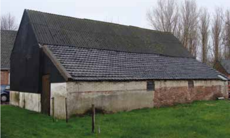
De verhoogde achterzijde met Tuile du Nord pannen op de ahang.
