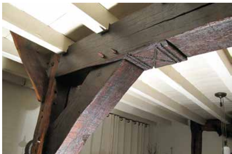
Gezaagde ankerbalk en schoor
