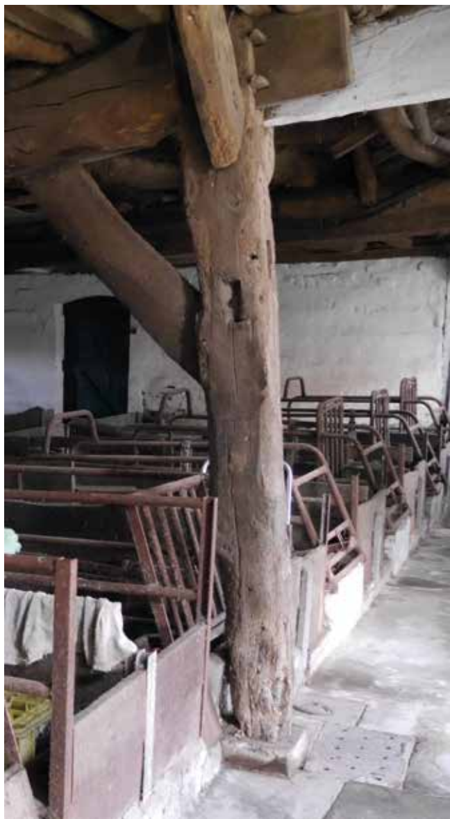
Een deels gekantrechte stijl met het dunne eind onderaan. De boomstam staat eigenlijk op zijn kop.
