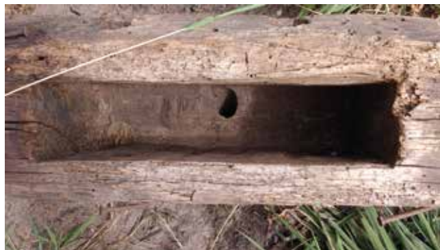
Een pengat. Onder in het gat zijn nog de uiteinden van de ronde boringen zichtbaar.
