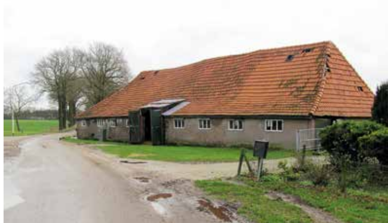
De schuur vóór de demontage. Pal links van de weg stond de Pannenhoef met 'de kont naar de weg'. De lantaarnpaal links op beide foto's is dezelfde.
