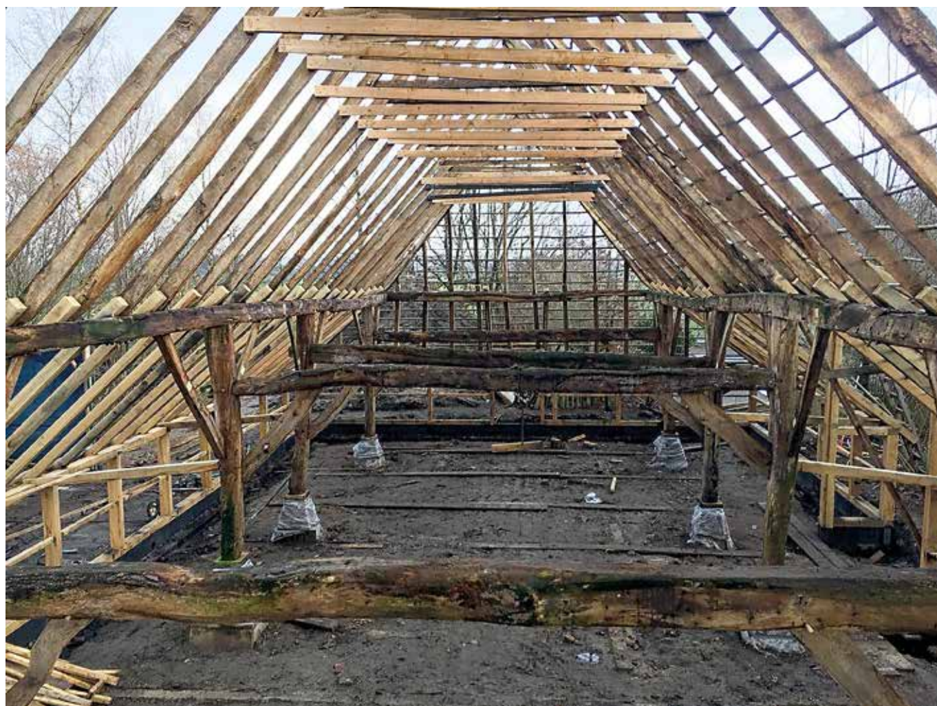
Eerst worden aan de buitenkant de stijlen en regels 'geleemd'.
