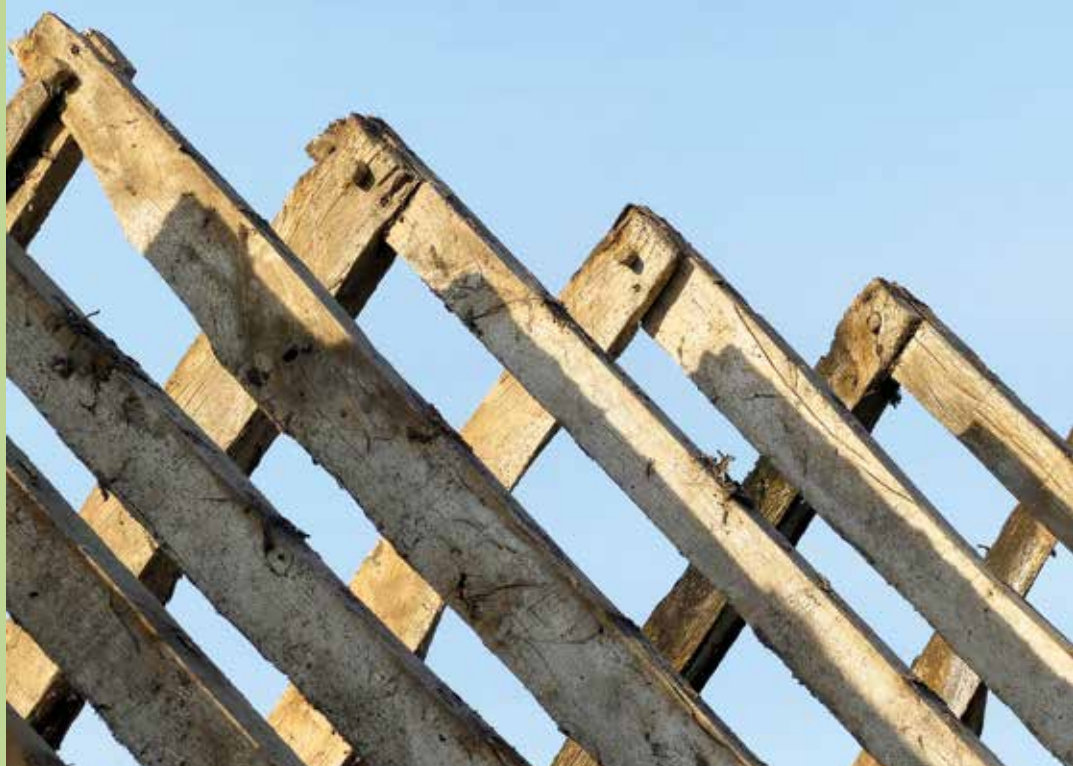
Gezicht op de 'nok' van de sporenkap van een schuur die van Vlierden naar Esch verhuisde.
