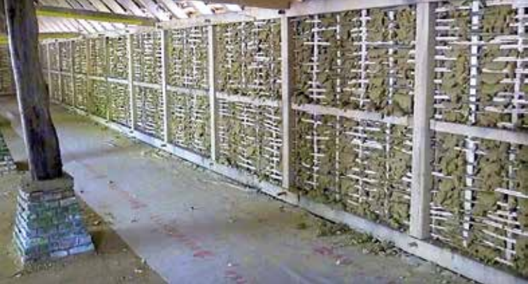
De zijgevel aan de binnenkant is nog niet gelemd.
