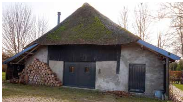
De achtergevel van hoeve Witven in Esch met daarin de potstaldeur
