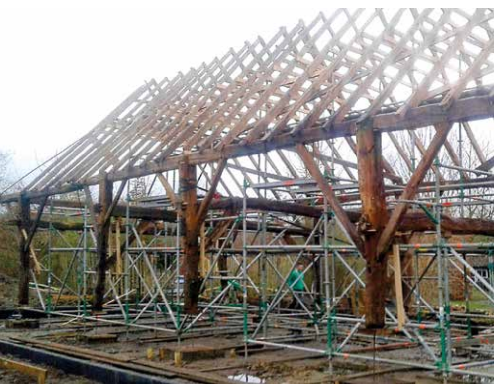
De schuur rust op de steiger en lijkt daardoor te zweven.
