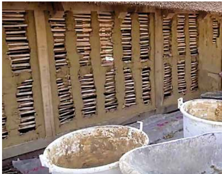
Eerst worden aan de buitenkant de stijlen en regels 'geleemd'.
