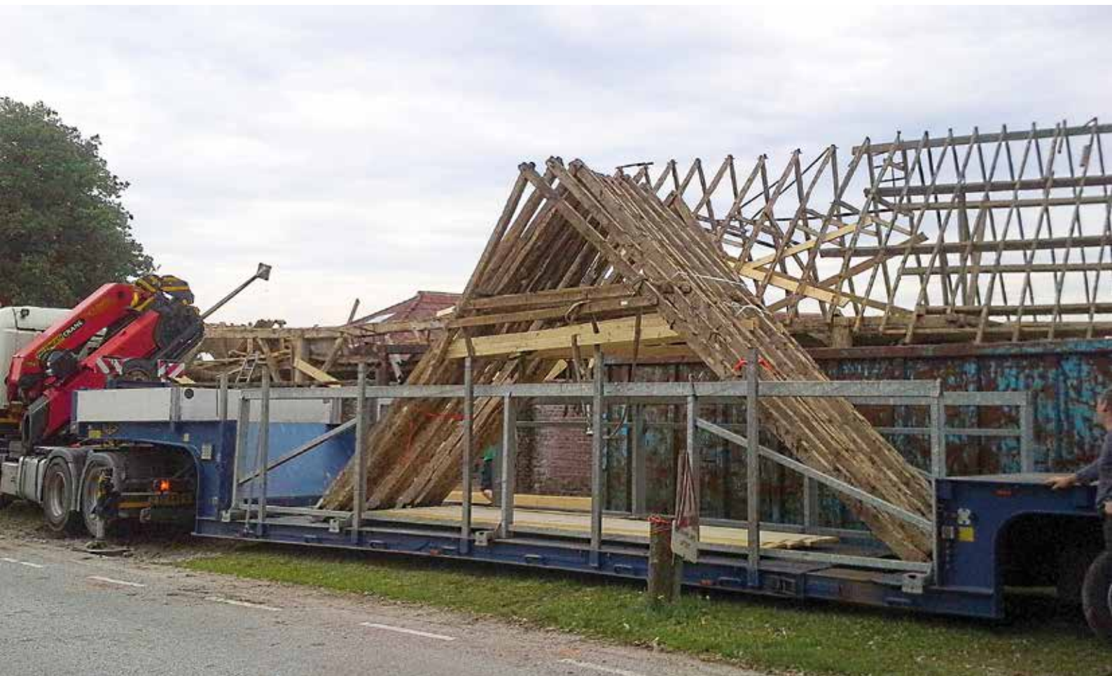
De sporensantjes worden rechtop vervoerd in een stalen kist op een dieplader.
