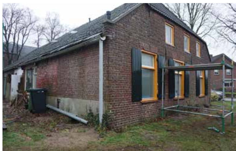
De restauratie is in gang gezet.
