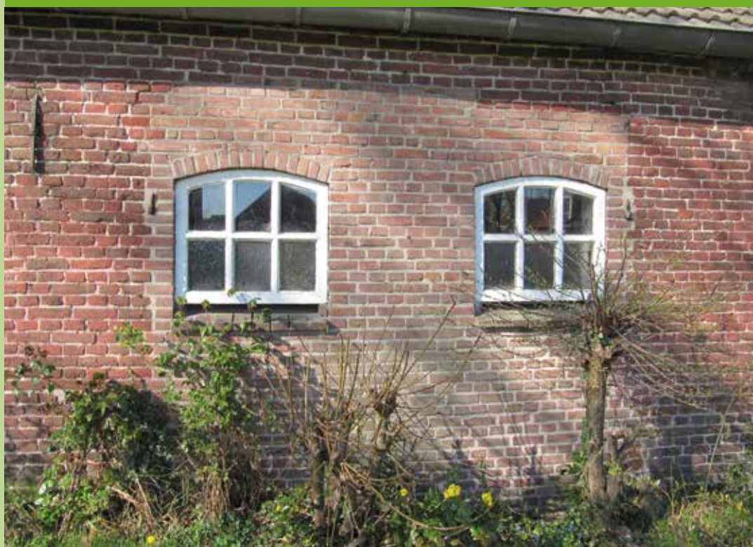
De dichtgemetselde potstaldeuren van de Boerdonkse boerderij. De duimen van de deuren zijn nog aanwezig.
