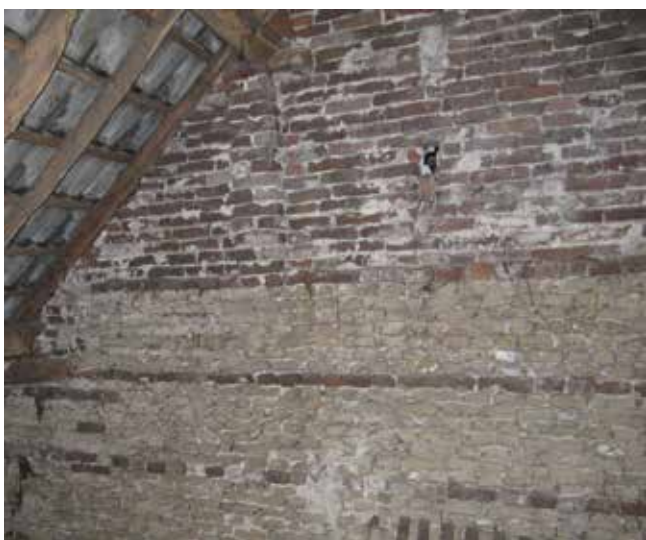
De brandgevel met deels gele en deels rode baksteen.
