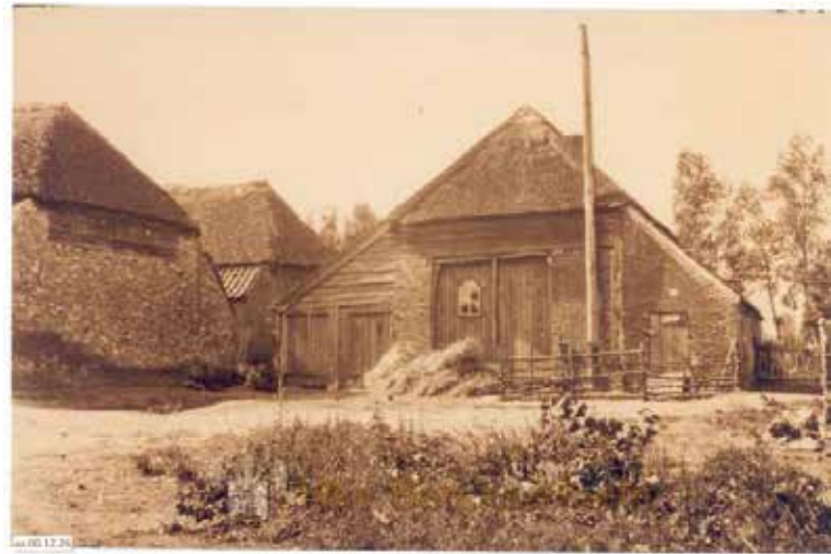
Afb 4. Voormalige boerderij aan de Deursenseweg 15-17 in Berghem omstreeks 1930 (afgebrand in de jaren '30) met een van glas voorzien vagevenster in het karakteristieke patroon van Berghem. Oorspronkelijk hadden de ramen geen glas en werden vanuit de binnenzijde afgesloten met houten luiken. De boerderij zelf is uniek, deels nog van hout met vakwerkrestanten in de muren. Foto collectie heemkundekring Berghem.
