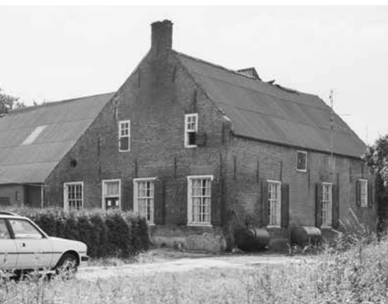
Afb 7. Oude, nog bestaande boerderij in de Harenseweg te Berghem, een voorbeeld van open ronde luchtopeningen in de zijgevel. In dit geval ter ontlichting van de ruimte boven de melkkamer.
