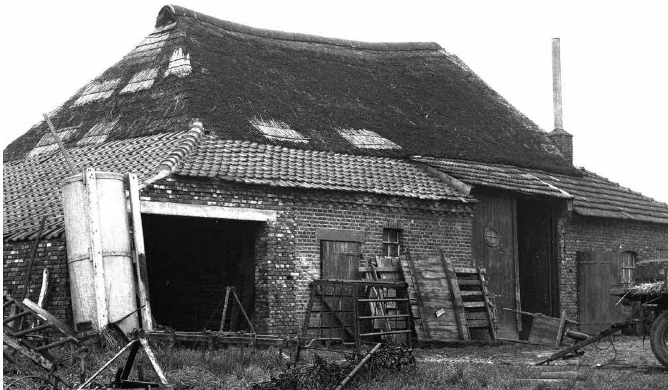
Afb 6. Voormalig 17e eeuws uitgebouwd hallehuis aan het Daalderstraatje 1 te Huisseling. Zichtbaar is het open uilengat in de nok en het ronde raampje in één van de staldeuren. Hier is mogelijk sprake van een voorloper op de huidige oogvormige raampjes. Foto collectie RCE.
