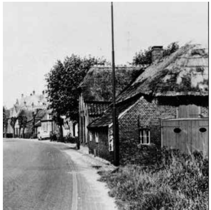
Afb 5. Voormalige boerderij aan de Kerkstraat-Puttelaar in Zeeland. In de staldeuren de oogvormige raampjes zonder glaswerk. Hierin is de oorspronkelijke oogvorm nog herkenbaar.
