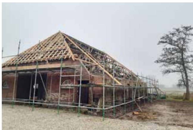
De schuur van de Emmahoeve wordt gerestaureerd (foto Joris van de Zanden)
